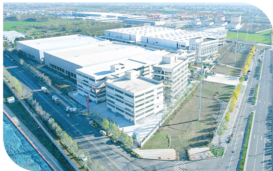
示范区冷链物流园区
