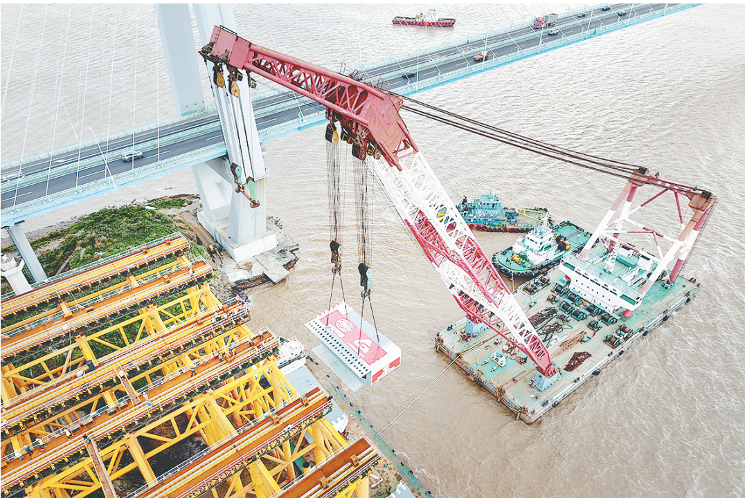
9月8日，由中国铁建大桥局承建的甬舟铁路桃天门公铁两用大桥首节钢箱梁架设完成，标志着甬舟铁路三座跨海桥梁全面进入架梁建设新阶段，为全线贯通奠定基础。
