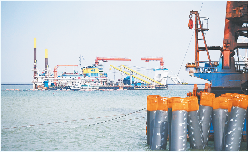
10月14日，在黄骅港散货港区原油码头一期工程项目现场，工人正在进行吊装钢管桩准备工作。 近日，由中国交建承建的河北沧州黄骅港散货港区原油码头一期工程项目沉桩工程正全力推进中。该项目包含1个30万吨级油品泊位及总罐容90万立方米的库区等配套设施，设计年通过能力1420万吨。项目建成后，将有效提升黄骅港原油运输基础设施保障能力，加快推动黄骅港转型升级、打造现代化综合服务港和国际贸易港。 新华社发（冯奕超 摄）
